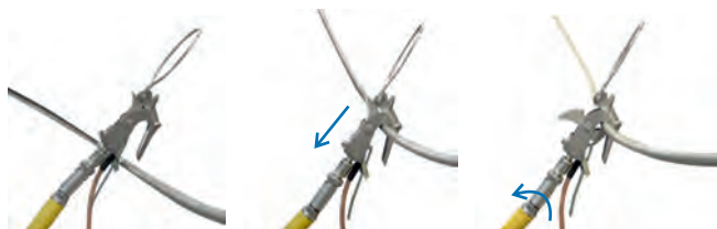
APLICARE CLEMĂ - OPERATOR POZIȚIONAT SUB CONDUCTOR
